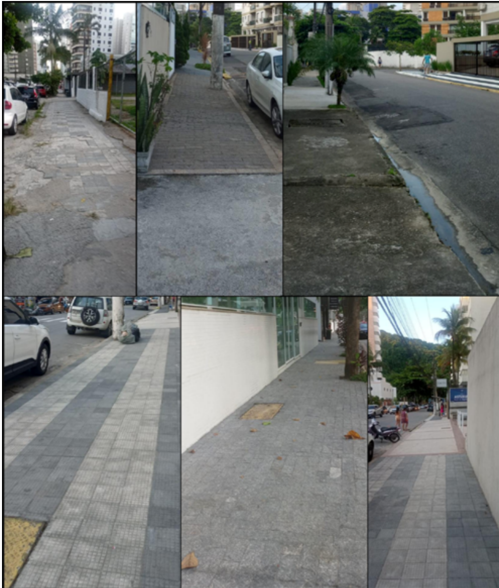
Figura S8. Calçadas irregulares e/ou perfuradas indicando pavimento de baixa qualidade nas vias urbanas do município de Guarujá.
